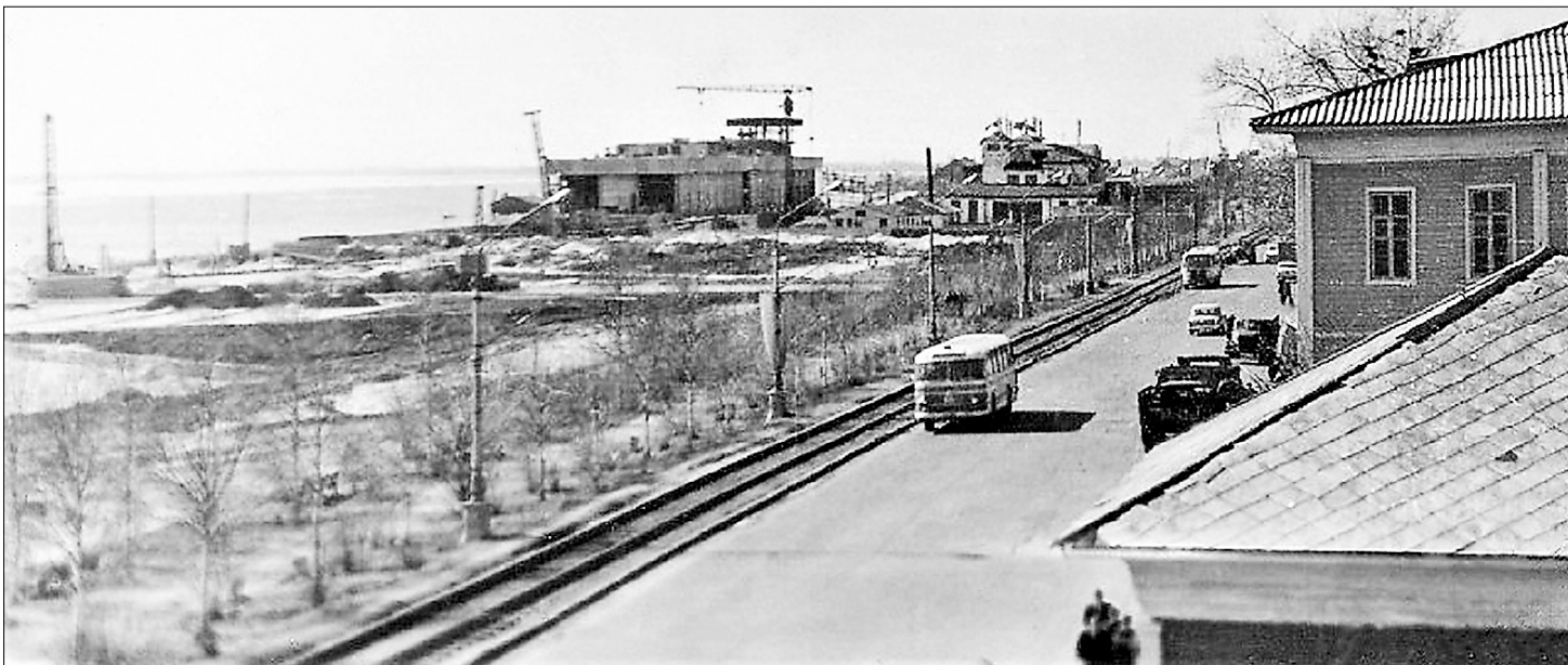
Строительство здания морского-речного вокзала. ФОТО: PASTAR.RU
