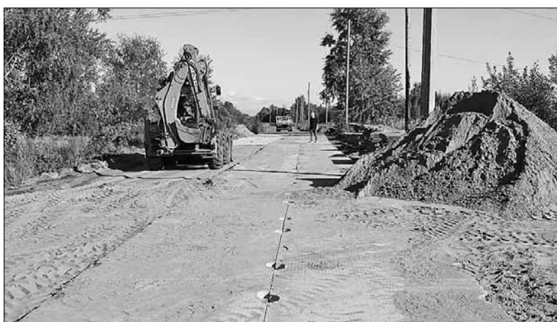
■ Центральную дорогу из плит отремонтировали в 2023-м. На двух участках плиты заменили полностью
