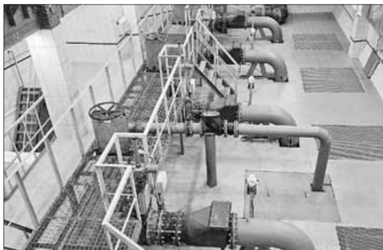
**■ В ходе реконструкции станции установлены пять новых насосов мощностью 1300 кубометров в час каждый**
